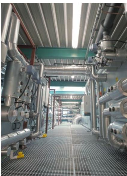
Pumpenstationen für Konditionierungsanlage
