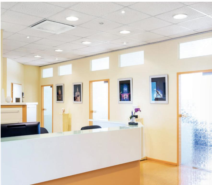
Krankenhäuser und Labors stellen besonders strenge Ansprüche an die Hygiene, auch bei der Belüftung und Klimatisierung. Die Hygiene-Deckenkassetten im Euroraster sind speziell für diesen Einsatz entwickelt worden. Sie sind nach VDI 6022 Teil 1: 2018-01 zertifiziert und mit einem integrierten Filter der Klasse F7 ausgestattet.
