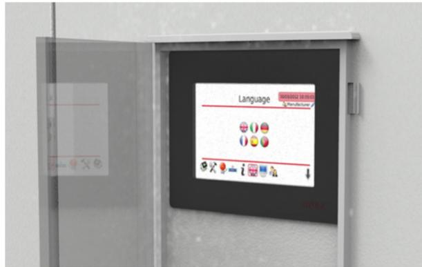
Die WPA-Kaltwassersätze werden vom STULZ C2020 geregelt, der speziell dafür entwickelt wurde, die volle Leistungsfähigkeit jeder einzelnen Komponente auszuschöpfen und diese durch die hohe Rechenleistung und Speicherkapazität optimal anzusteuern.
