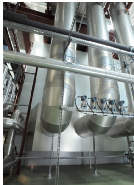
Czujniki ciśnienia do instalacji kondycjonującej
