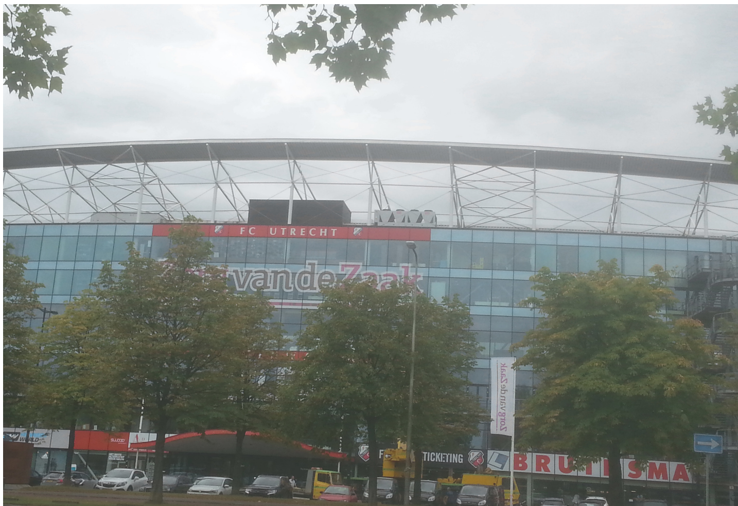
De nieuwe chiller op het hoofgebouw van Stadion Galgenwaard in Utrecht.
