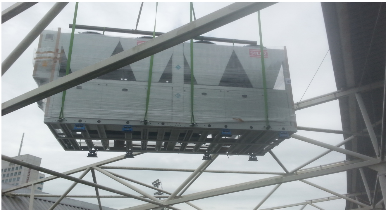
De STULZ Chiller die op het dak van het stadion wordt gezet.
